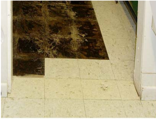
(g) Kitchen Floor Tile Mastic F1
