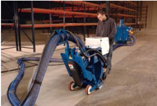
Fig. 8.12.a: Shotblasting warehouse floor
