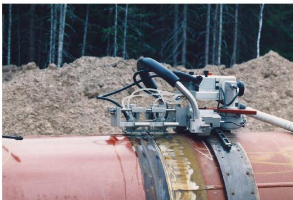
شکل 8: بازرسی خط جوش یک لوله با اتصال Girth
