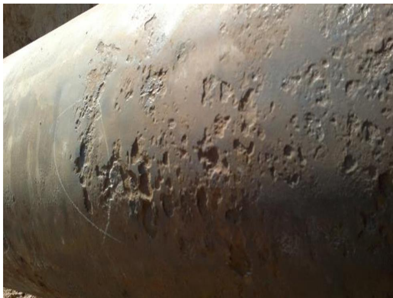
تصویر ۱۶- پر نمودن خوردگی خارجی سطح لوله قبل از اعمال غلاف
