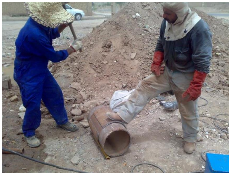
تصویر ۱۹- استفاده از یک نمونه لوله هم سایز جهت فیتاپ اولیه قبل از نصب به منظور جلوگیری از آسیب به لوله اصلی
