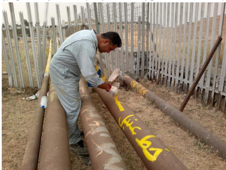
تصویر ۲۳- مارکینگ خط لوله مد نظر جهت تعمیرات
