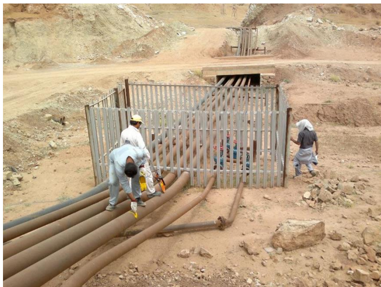
تصویر ۲۲- انجام عملیات جانمایی و survey خط لوله قبل از عملیات جوشکاری حین سرویس
