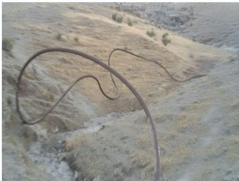
تصویر ۲۴- انفجار خط لوله یکی از مناطق نفتخیز به دلیل برشکاری جابجا در خط لوله
