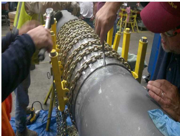
تصویر ۱۷- فیتاپ غلاف بر روی لوله با استفاده از تجهیزات باربرداری به منظور فیتاپ حداکثری
