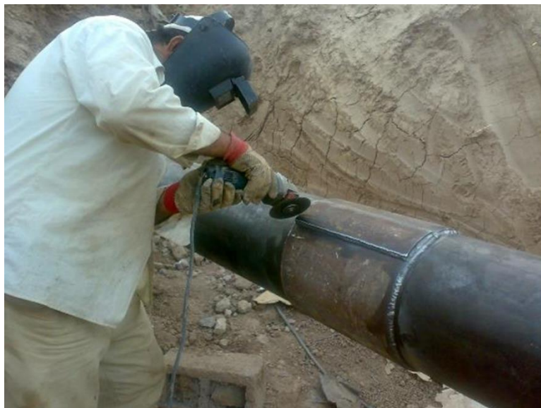
تصویر ۱- استفاده از غلاف محیطی برای تقویت نواحی خورده شده خطوط لوله
