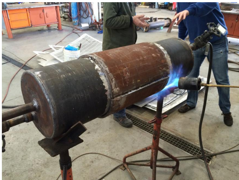
تصویر ۷- انجام دستورالعمل شبیه سازی شده SISWPS جهت تایید دستورالعمل جوشکاری غلاف حین سرویس
