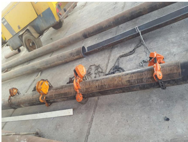
تصویر ۱۸- فیتاپ غلاف بر روی لوله با استفاده از چین بلاک به منظور فیتاپ حداکثری
