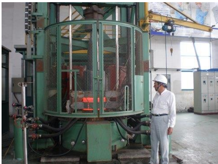
شکل ۶-۱۳- عکسی از کوره القایی فرکانس بالا برای عملیات حرارتی سخت کاری سطح غلتک
